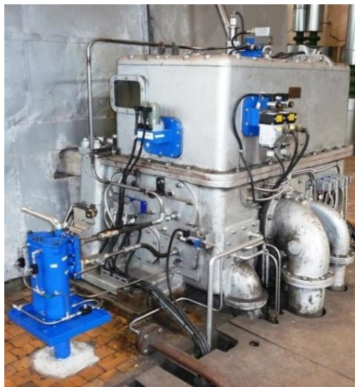
Rekonstruovaný přední ložiskový stojan
